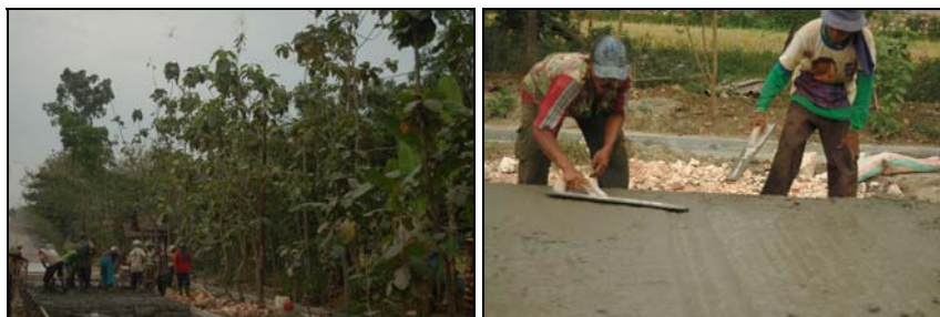
Perbaikan jalan sepanjang menuju Blora.
